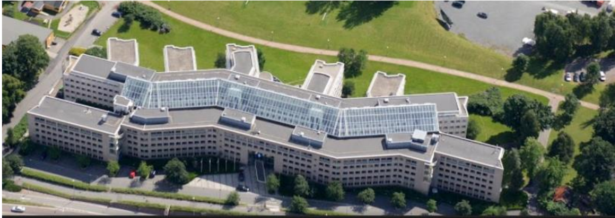
Figur 7: Drammensveien 288, oppført i 1999, og har ansvar for drift av strandområdet på Sollerudstranda. Flere leietakere holder til her. Kilde Bærum kommune.
