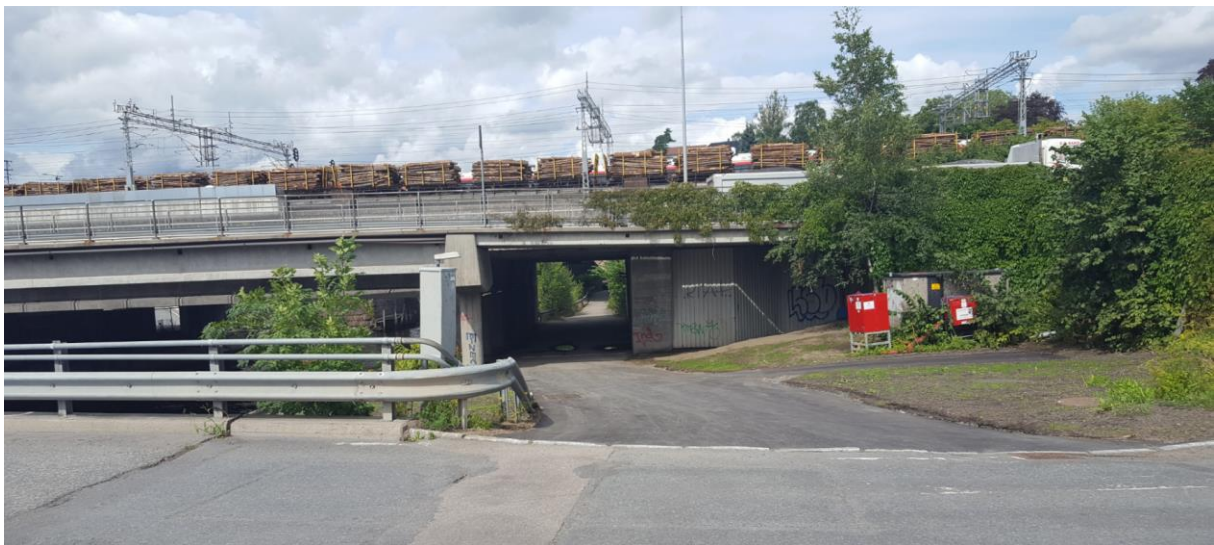
Figur 11: Landskapet i planområdet er generelt preget av barrierer: bruer for infrastruktur som E18 og jernbanen. Dette deler Lysakerområdet. Tverrforbindelse for gående er turveg på Oslosiden av elva som går frem til Sollerudstranda via undergangen under E18 eller på fortau langs Strandveien. Foto: Asplan Viak.
