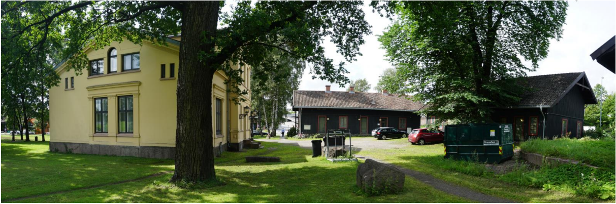
Figur 5: Eksempel på kulturminne innenfor planområdet: Sollerud gård. Hovedbygningen ble oppført i 1871 ved arkitekt H.E. Schirmer. Foto: Asplan Viak
