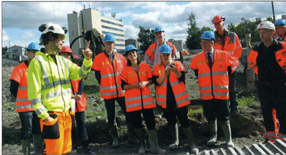
FORKLARER. Sindre Flakstad, stikningsingeniør i Veidekke, forklarer representantene fra Nærings- og handelsdepartementet og sentrale personer i prosjektet hvordan anleggsmaskinene tar i bruk modelldata.
